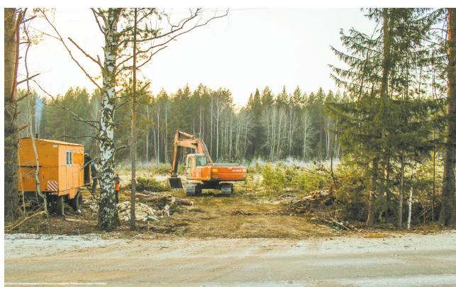
Работы по закладке фундамента
